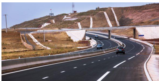
L'autoroute qui relie Dakar à Diamniadio, remportée par Eiffage, a constitué une exception sous le régime Wade.
