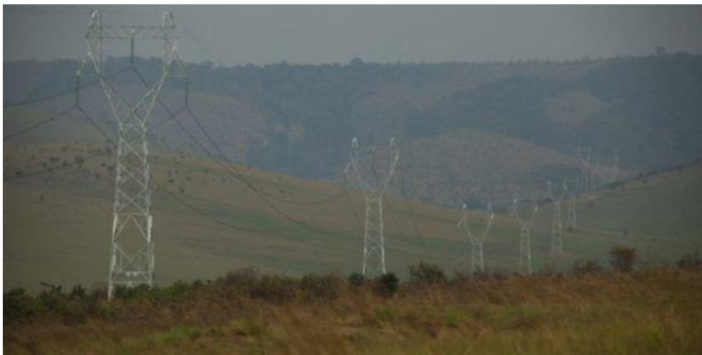
Pylônes électriques au Congo-Brazzaville
